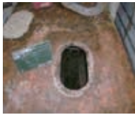
①施工前 (既設マンホール)
