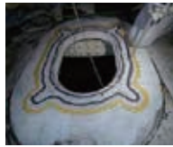
②施工中 (素地調整・接着剤塗布)
