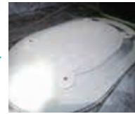
④施工後 (新設FRP製蓋設置)
