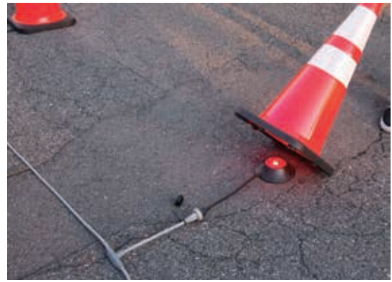
ケーブルとの接続状況
