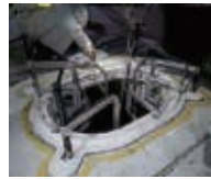
③施工中 (水切FRP接着接合)
